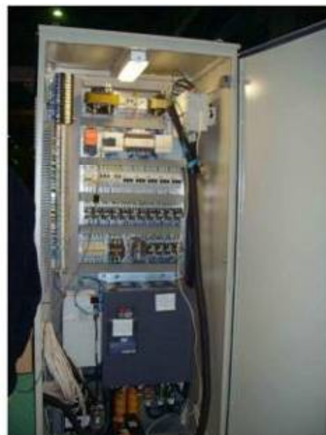
Рисунок 4. Пульт управления и электрошкаф установки для динамической стабилизации.
