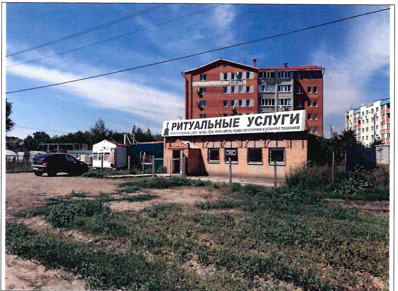
Изображение 4. Фотография объекта капитального строительства
